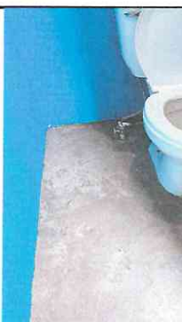
Foto 4: Reemplazo de suelos, por concreto con espesor de 8 centímetros en el area de baños
