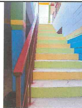
Foto 2: Reemplazo de pintura por pintura anticorrosiva en baranda, hacia el segundo nivel de aula 1 y 2
