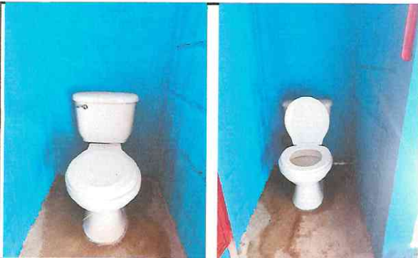
Foto 3: Reemplazo de seis sanitarios en mal estado en area de baños
