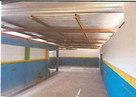
Foto 5: Sustitución de lámina actual (acanalada) en mal estado, por lamina troquelada calibre 26 legitima, en area de patio
